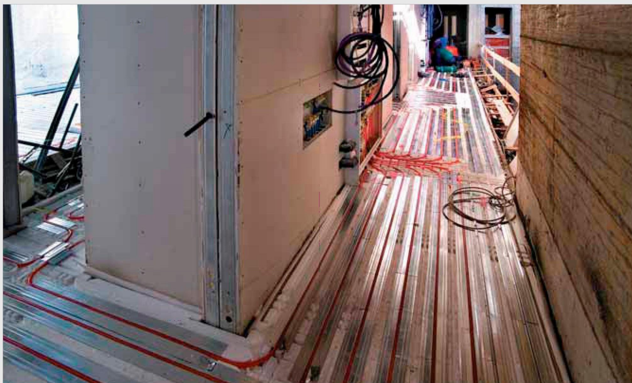
Част от подова инсталация с разпределение от колекторна група R559
