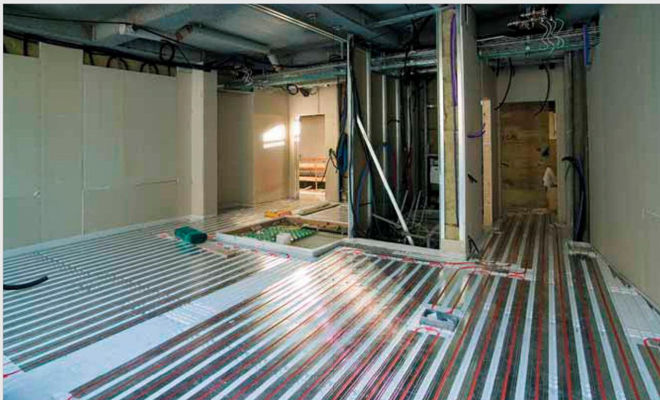
Монтаж на подова инсталация
